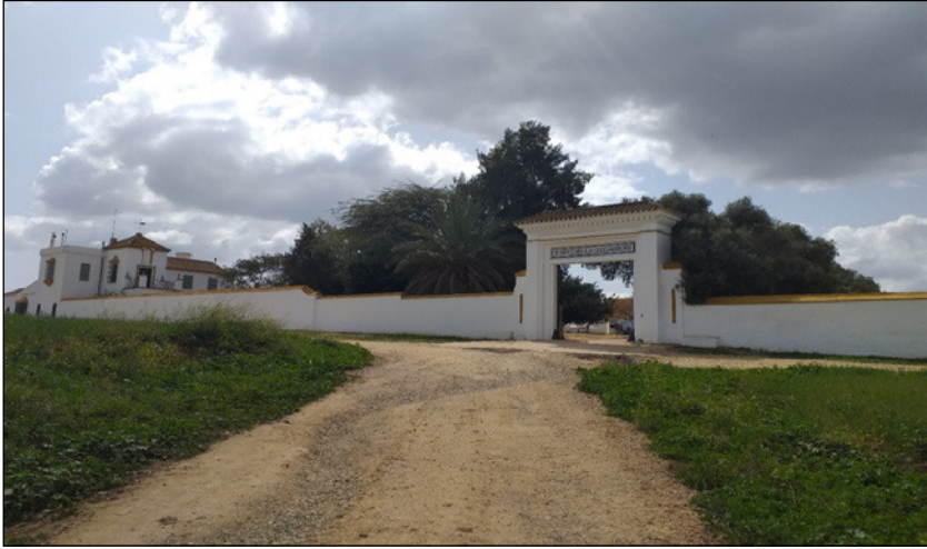
Fig. 19. Vista del caserío de la finca Espechilla-Algarrobí.
