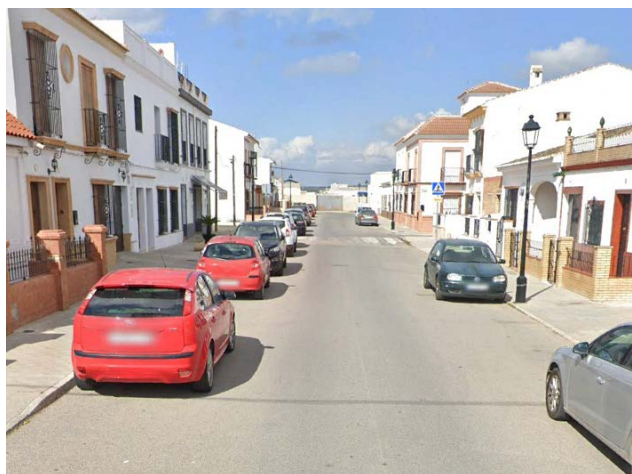
Calle Doce de Octubre. Fuente: Street View Google Earth (2025).
