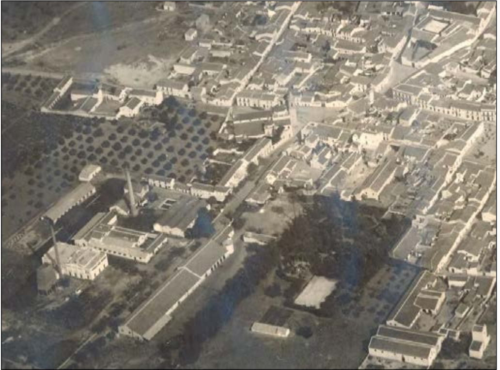
Imagen: Sección de la fotografía aérea de Pilas realizada por el aviador Fco. Medina (ca. 1928). En la parte inferior se observan las fábricas de Luis Medina Garvey, con sus icónicas chimeneas y el jardín de recreo. Y en la esquina superior derecha aparece la Casa Grande (La Portá o hacienda de los Esquivel) donde vivió desde 1904.
