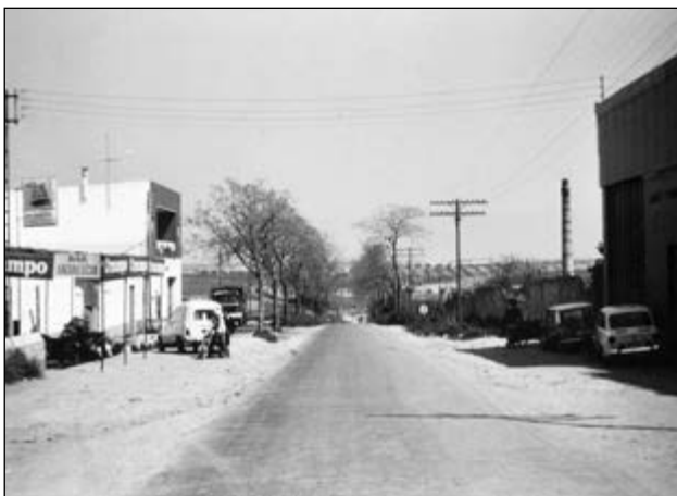
Foto: Avenida del Aljarafe, donde se pueden observar postes y cableado de la línea de luz eléctrica. A la izquierda se ve el Bar Andalucía y a la derecha la chimenea de la fábrica de mantillo. s/f (ca. 1960). AMFFSMP.
